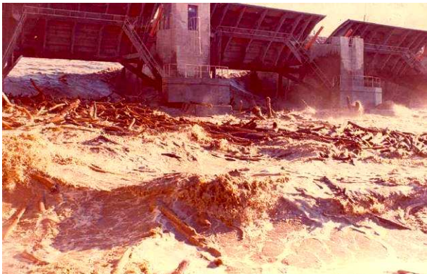
ESTRUCTURA DE DERIVACION DEL RÍO NEUQUÉN A LOS BARREALES EN PORTEZUELO GRANDE
