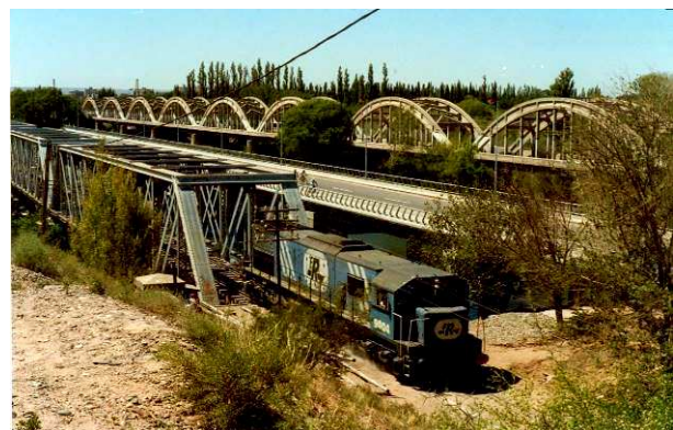
PUNTES CARRETEROS Y FERROVIARIO. COMUNICACION ENTRE CIPOLLETTI Y NEUQUEN
