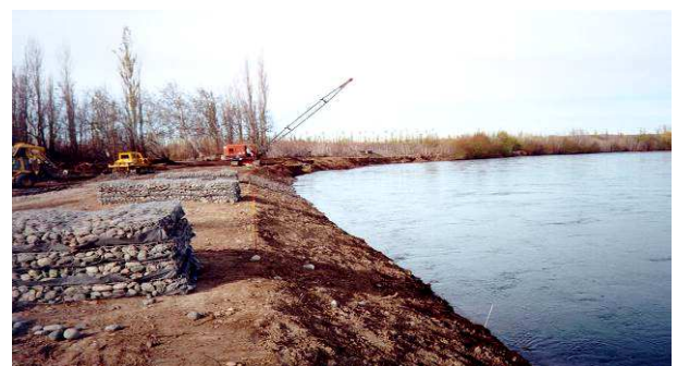
OBRA DE PROTECCION DE MARGENES
