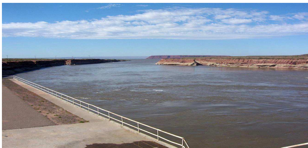
CANAL DE DERIVACION DEL RIO NEUQUÉN A LOS BARREALES EN PORTEZUELO GRANDE
