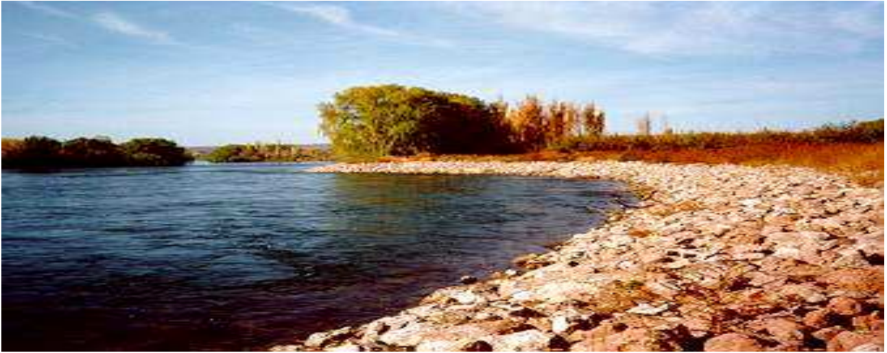
OBRA DE PROTECCION DE MARGENES
