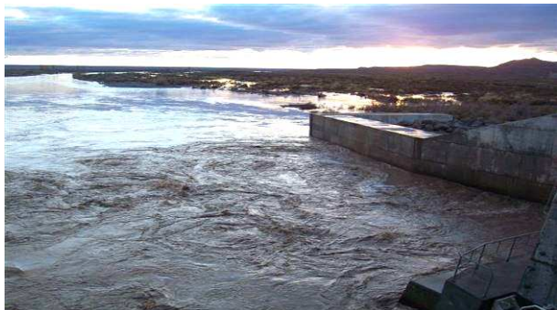
CRECIDA DE JULIO DE 1996 - PORTEZUELO GRANDE, VISTA HACIA AGUAS ABAJO
