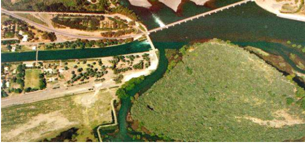
DIQUE RODOLFO BALLESTER, CANAL DE RIEGO Y CANAL DERIVADOR AL LAGO PELLEGRINI
