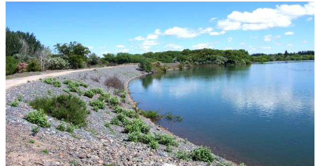
OBRA DE PROTECCION DE MARGENES
