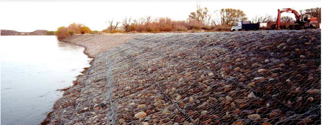
OBRA DE PROTECCION DE MARGENES
